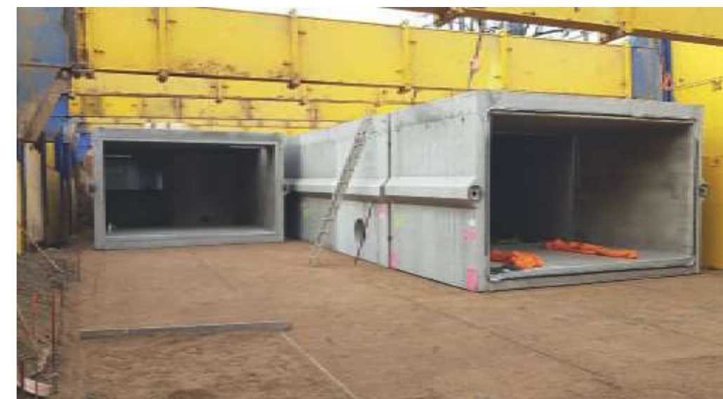
Fertigteileeinbau bei der Kanalarstellung
