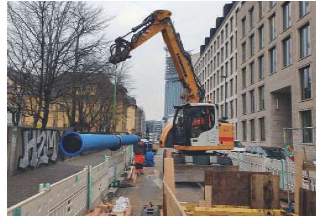
Bauabschnitt Hohenstaufenstraße, Einbaubaugrube
