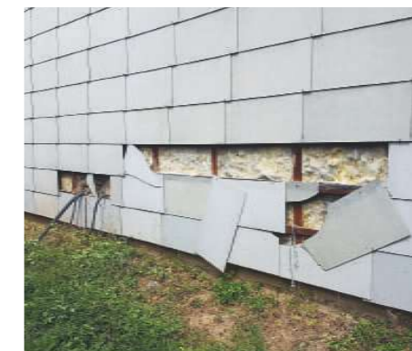
Schadstoffbelastete Bauteile: Asbesthaltige Fassadenbekleidung, KMF-Dämmung im Fassadenaufbau, PCB/PAK-haltige Beschichtung
