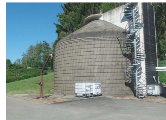
Schadstoffbelastete Bauteile: Asbesthaltige Fassadenbekleidung, KMF-Dämmung im Fassadenaufbau, PCB/PAK-haltige Beschichtung
