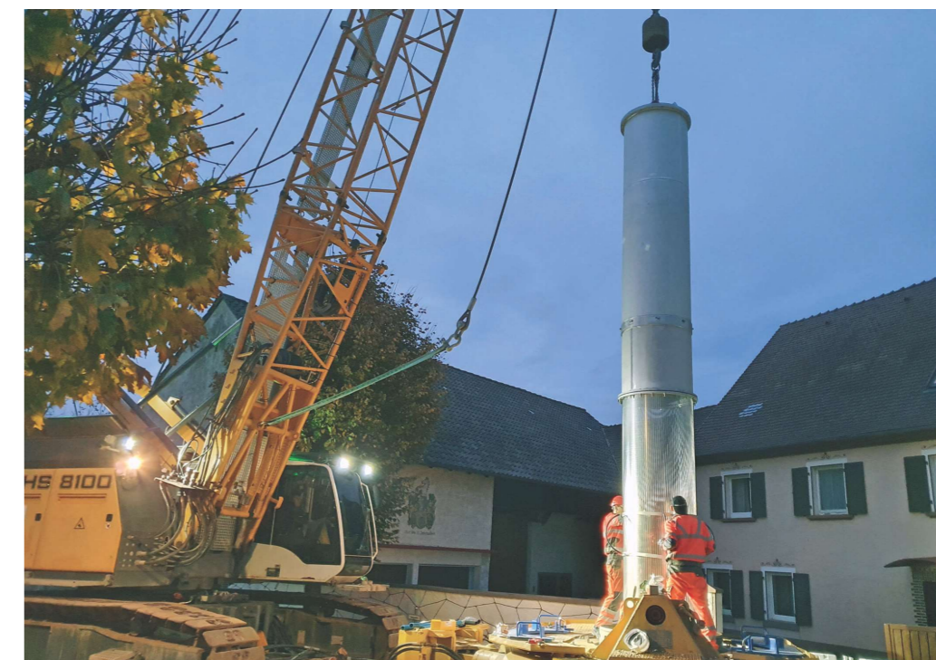
Bau eines Schutzbrunnens im innerörtlichen Bereich von Hochstetten
