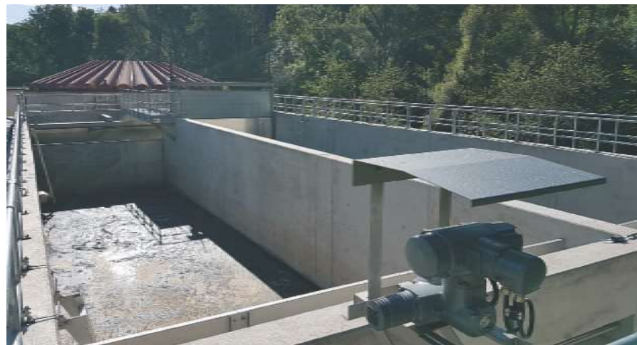
Kläranlage Neuhausen a. d. F. - RÜB nach der Fertigstellung
