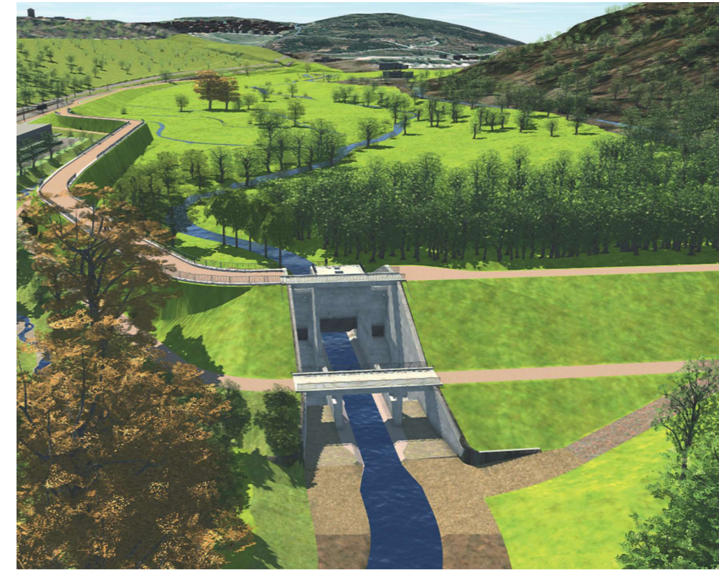
Blick von Norden auf das Hochwasserrückhaltebecken Spinnerei mit Durchlassbauwerk
