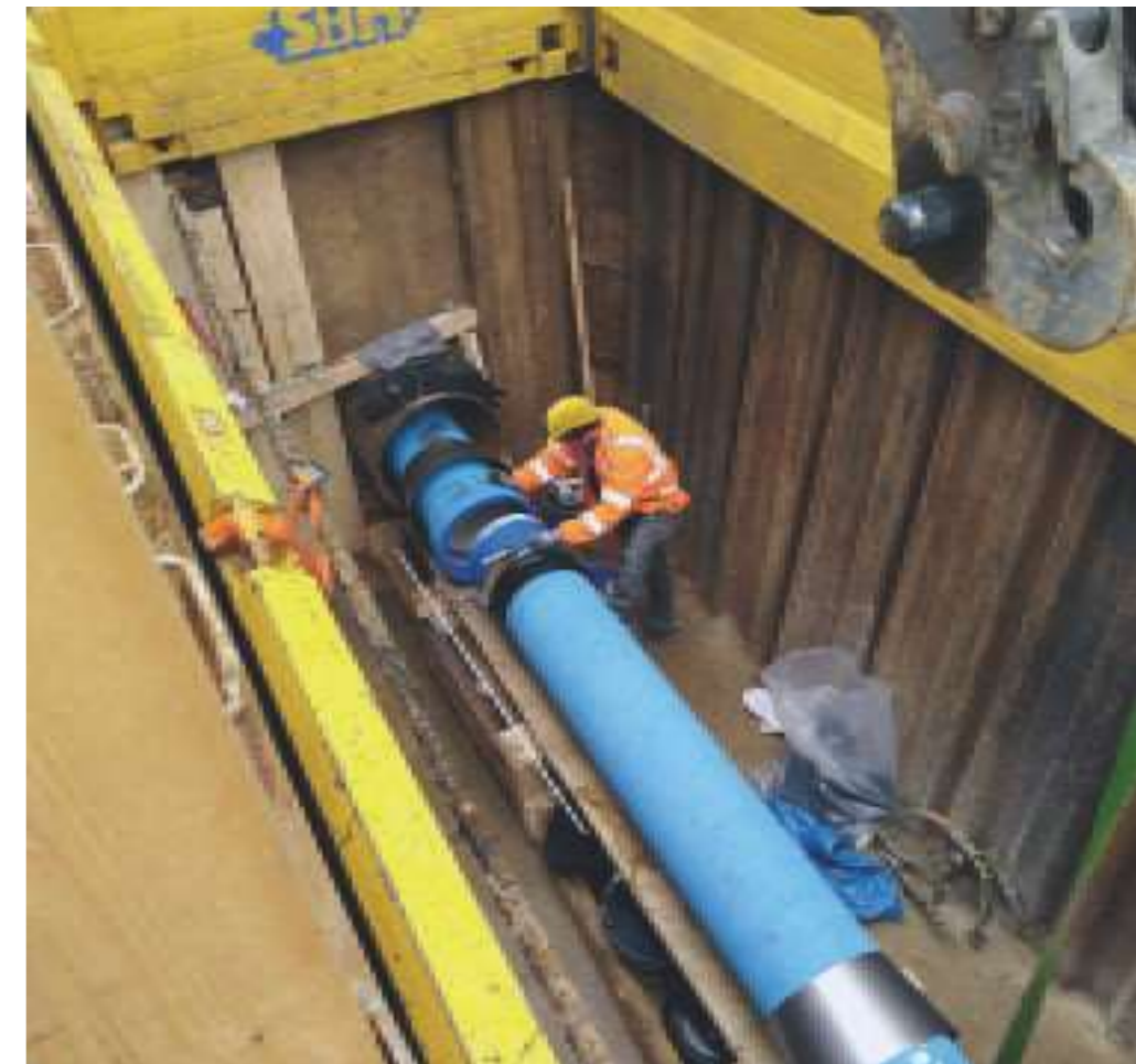
Bauabschnitt Hohenstaufenstraße, Einbaubaugrube
