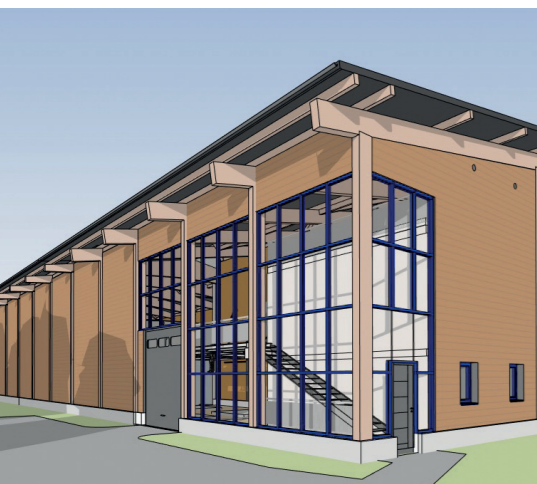
Wasserwerk in Holzständerbauweise
