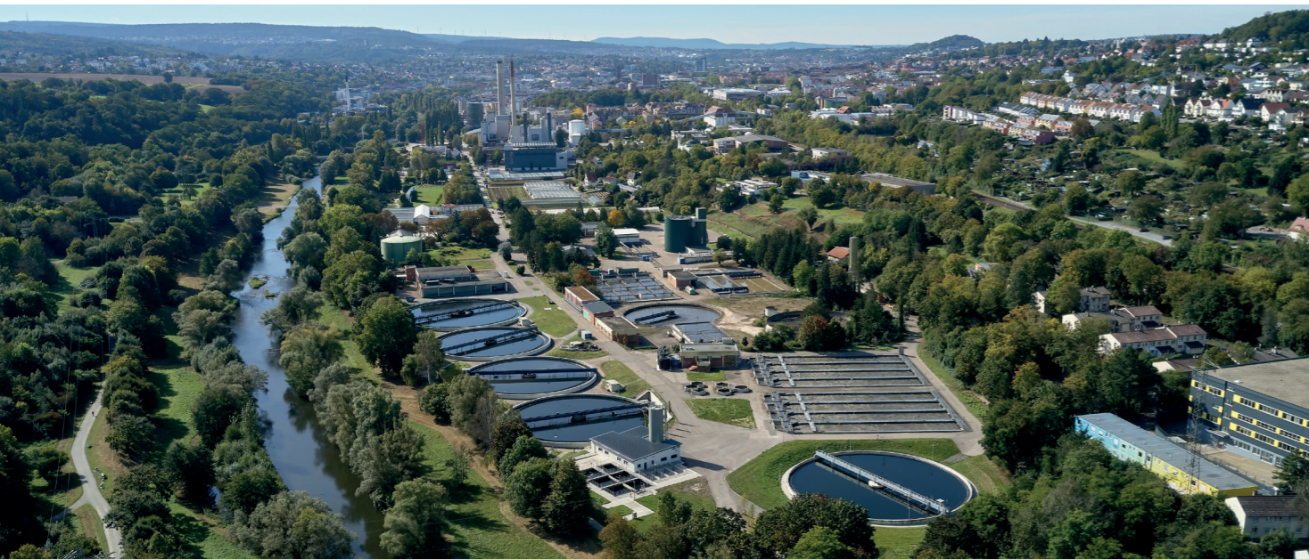
Stadt Pforzheim (im Vordergrund die Kläranlage mit 4. Reinigungsstufe), Bildquelle: Eigenbetrieb Stadtentwässerung Pforzheim
