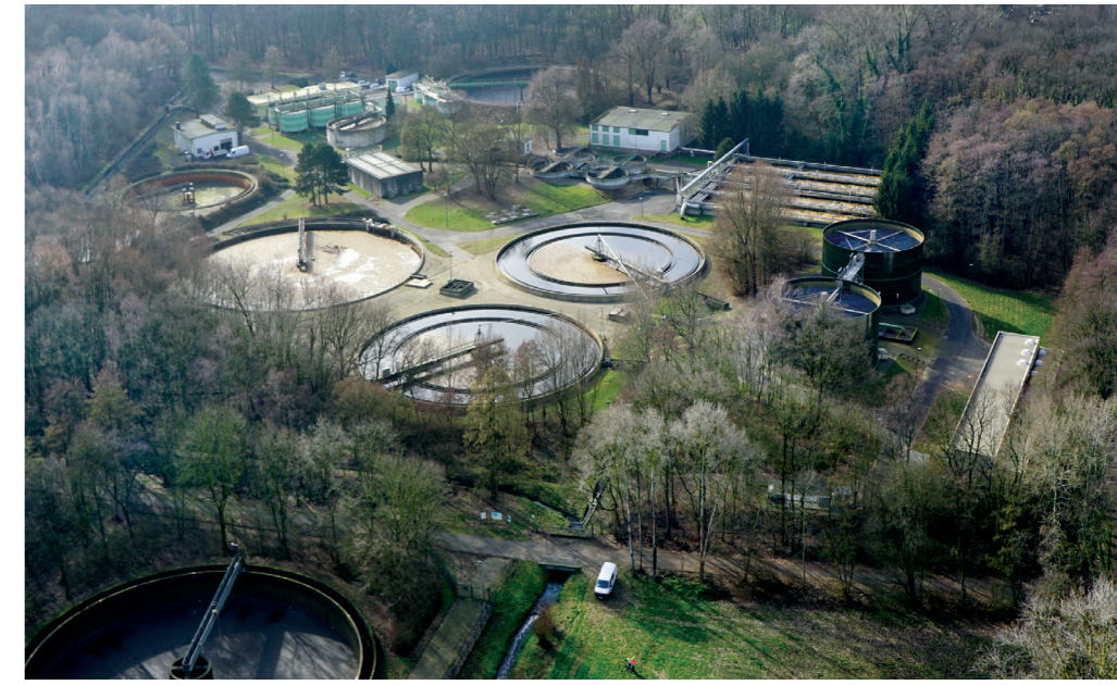
Luftaufnahme Kläranlage Nette, Quelle: Niersverband
