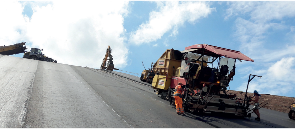
Fertigung Basisabdichtung
