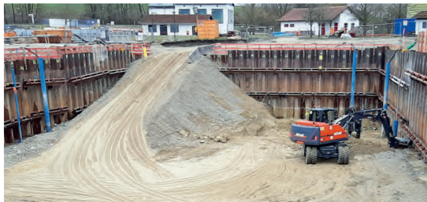
Baugrube mit rückverankerter Spundwand
