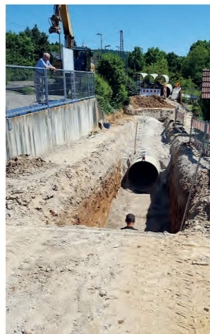
Mischwasserkanal GFK DN 1200
