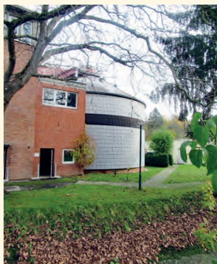
Kläranlage Kornwestheim – Faulbehälter
