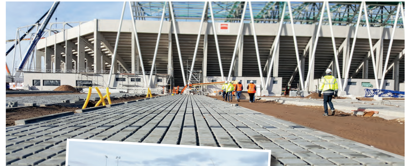
Neubau des Stadions in Freiburg
