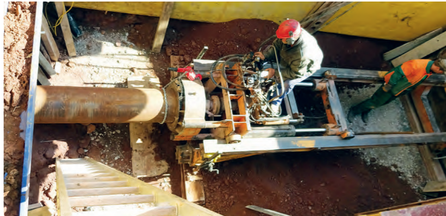
Vortriebsvorrichtung in der Startgrube
