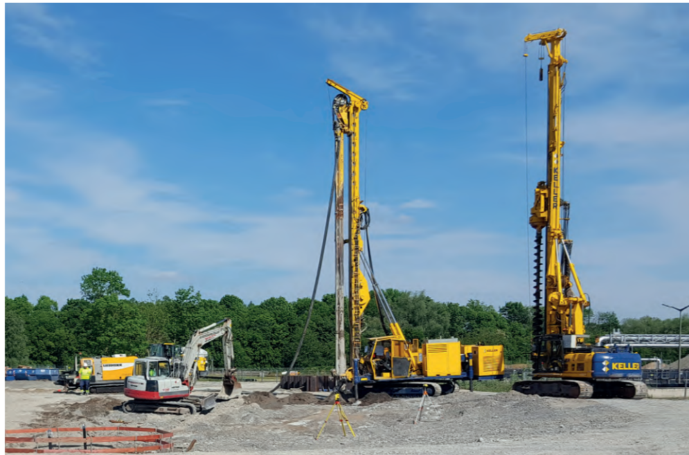
Herstellung Betonrüttelsäulen unterhalb der geplanten Sedimentationsbecken
