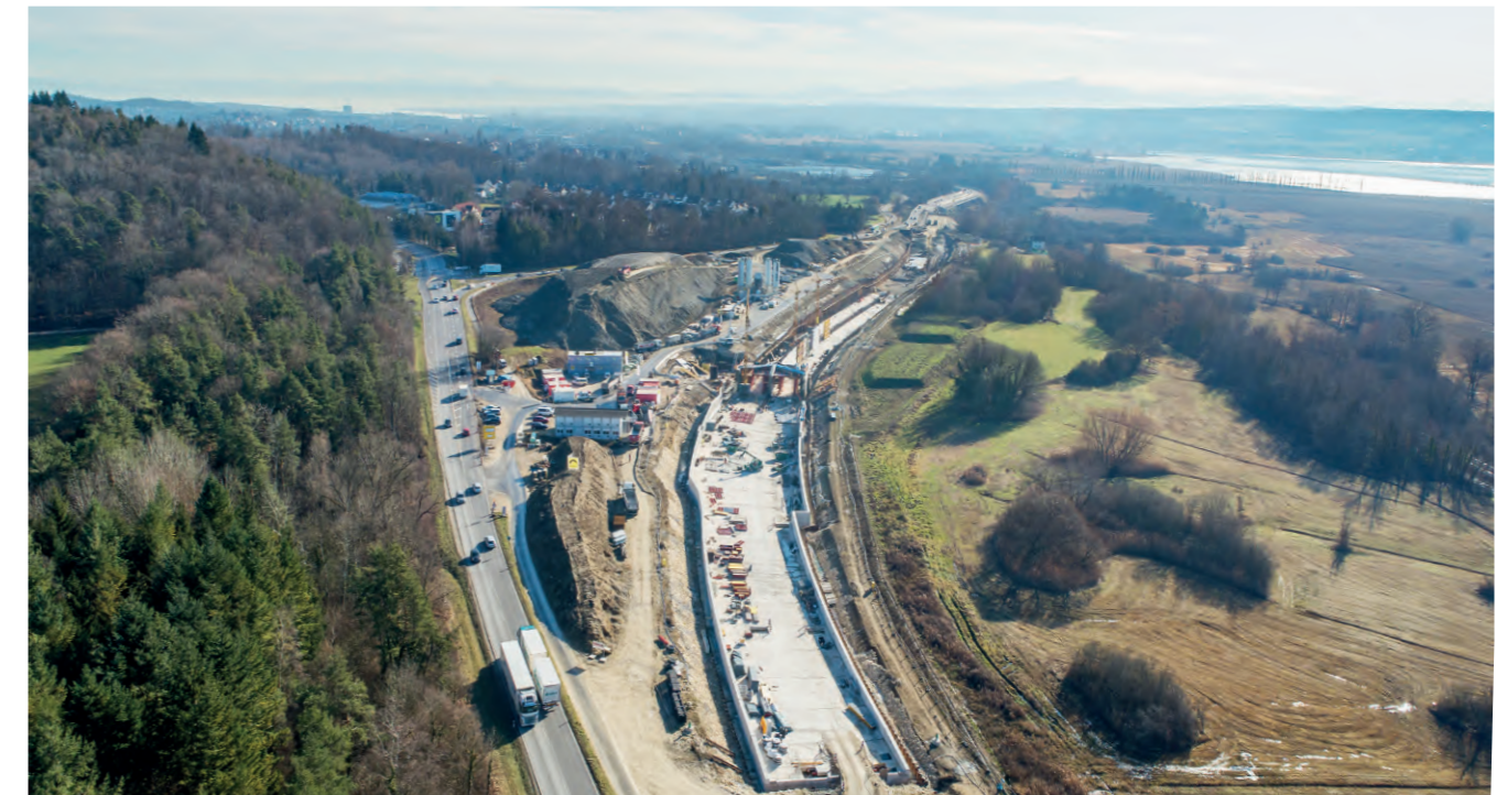
Bauarbeiten am Streckenabschnitt „Tunnel Waldsiedlung“
