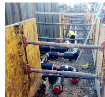
Verlegung Fernwärme
