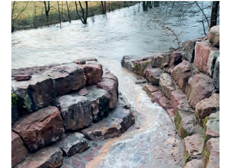
Auslaufbauwerk aus Buntsandsteinen
