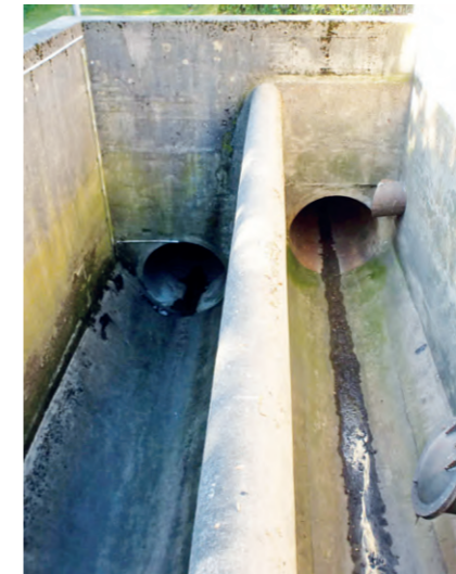
Beckenüberlauf, vor der Ausrüstung
