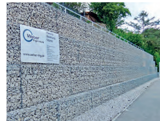
Neue Gabionenwand in Birkenfeld
