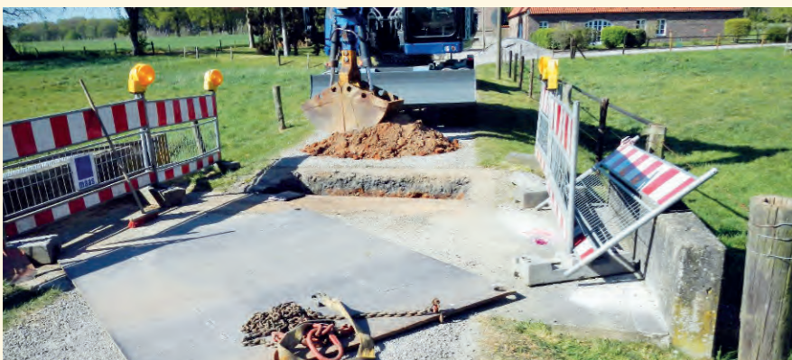
Durchlassbauwerk am Spechtshof
