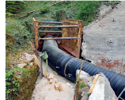
Entlastungskanal aus PKS Rohren
