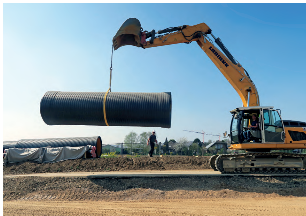
Verlegung der Großrohre
